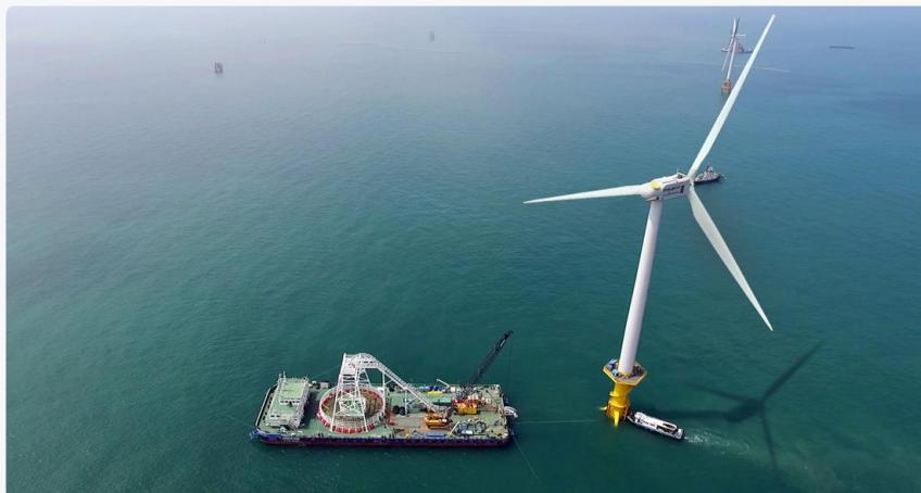
대한전선은 대한민국 최초의 대규모 해상풍력 사업인 서남해 해상풍력 단지의 R&D 사업 및 1단계 실증사업에 22.9kV 배전급 광복합 내부망 프로젝트를 낙찰받아 해저케이블을 생산 및 공급하였습니다. 해저케이블의 핵심인 방수, 내구성, 내오염성 등 고도의 성능 및 안정성을 위한 체계적 기계 시험 및 점검 실시 등을 통해 프로젝트를 성공적으로 완수하였습니다.
